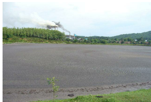
Gambar 2. Pengolahan POME dengan sistem kolam terbuka
