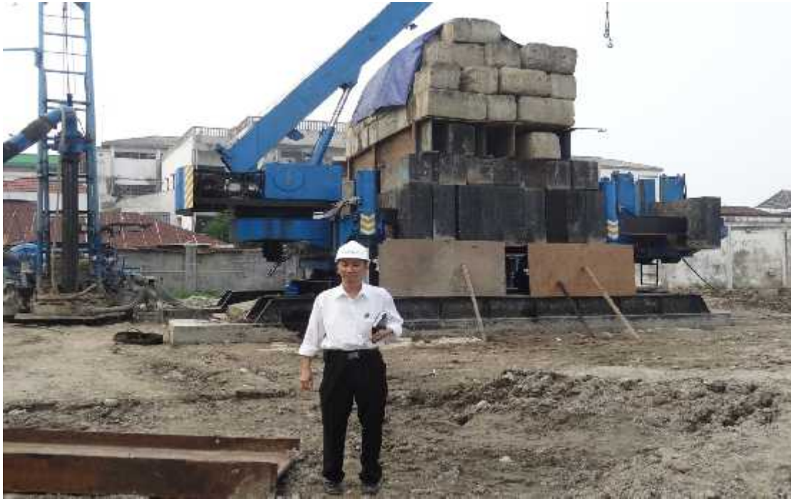
Pelaksanaan loading test dengan beban langsung ( Kentledge System ) pada pile no: 35 BP 80-31 yang dilaksanakan pada tanggal 18 September 2014
