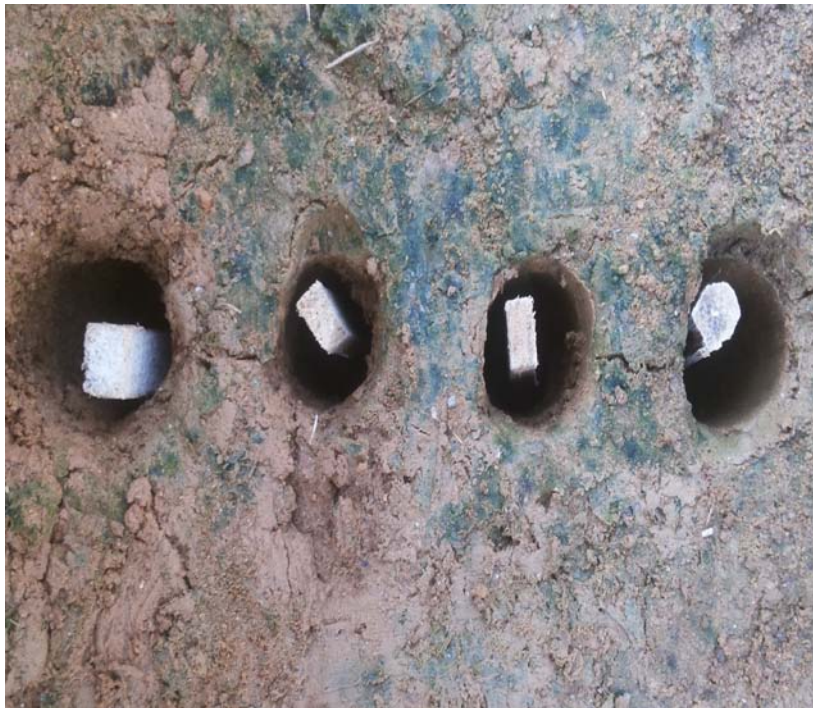
8. Pelubangan dinding saluran untuk pengukuran garis aliran rembesan
